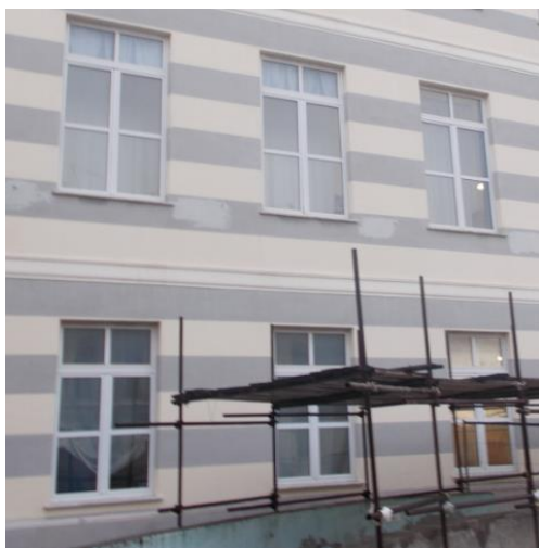
Figura 4.3 – Rilievo termografico della parete
