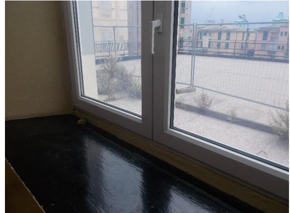
Figura 4.4 - Particolare dei serramenti
