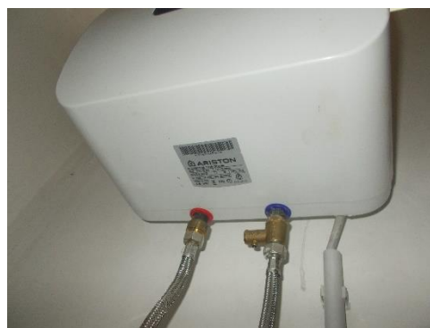
Figura 4.9 - Particolare di un boiler elettrico per la produzione di acqua calda sanitaria
