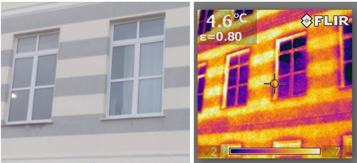
Figura 4.5 – Rilievo termografico dei serramenti
