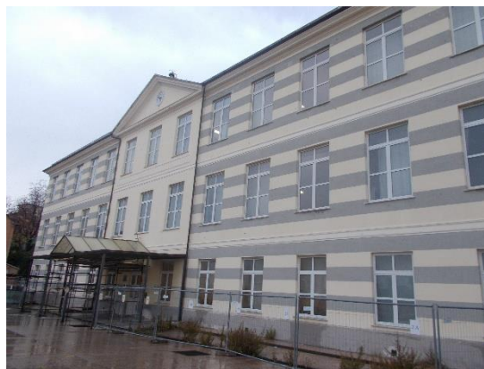
Figura 1.1 - Vista della facciata
